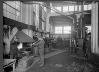
1931 Sepät työskentelevät Hietalahden telakan pajassa.
